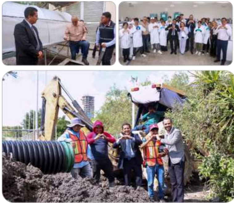
Figura 1. Trabajos de SOAPAP en la UPMP.
